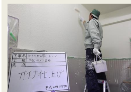
▲ガイナ施工中の様子
